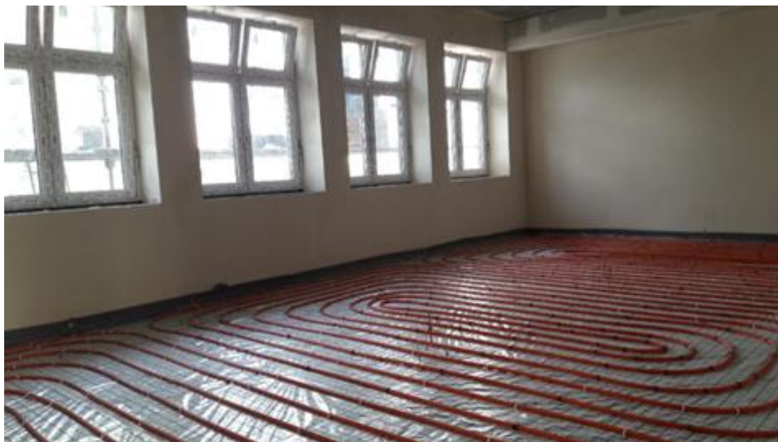
Ogrzewanie podłogowe pod wylewkę
