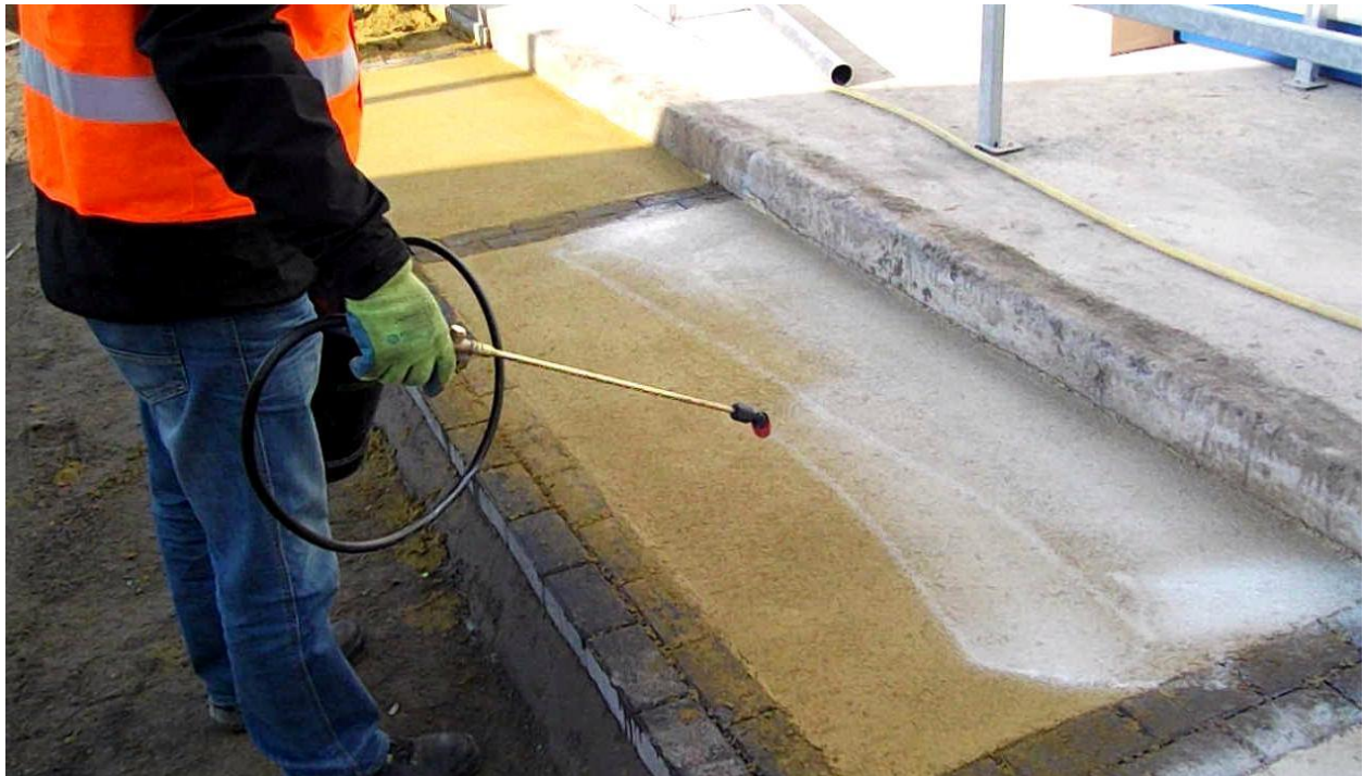
Rysunek 5. Nanoszenie dezaktywatora wiązania betonu
