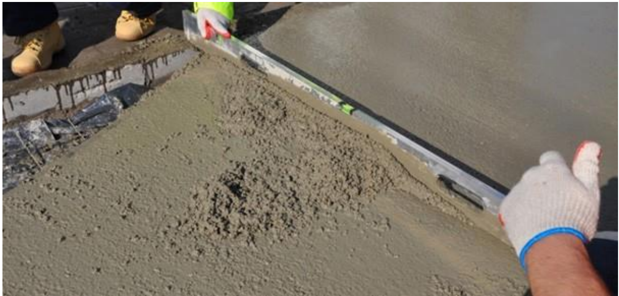
Rysunek 2. Układanie i wyrównywanie nawierzchni DECO STONE przy użyciu łaty
