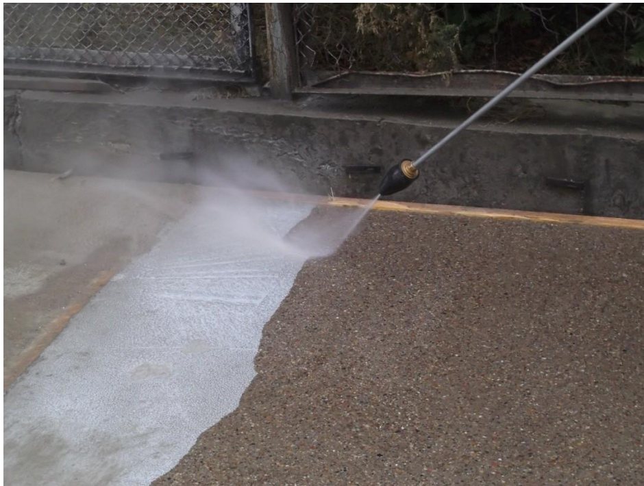
Rysunek 6. Eksponowanie kruszywa przy użyciu myjki wysokociśnieniowej.
