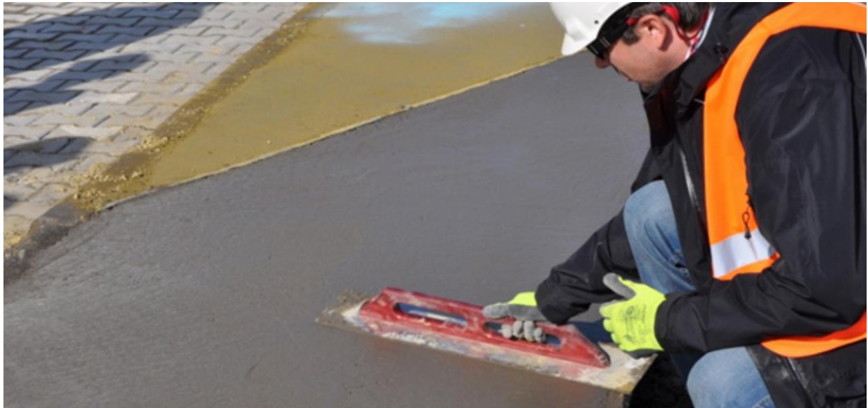
Rysunek 3. Wygładzanie nawierzchni stalową pacą - czynność tą należy przeprowadzić delikatnie, aby poprzez zbyt silny nacisk nie zatopić przypowierzchniowych warstw kruszywa w głębsze warstwy mieszanki betonowej
