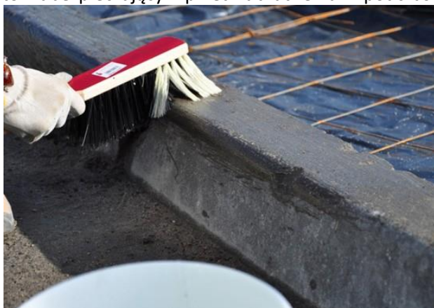
Rysunek 1. Nakładanie preparatu VBA Protector w celu ochrony otoczenia przed zabrudzeniami
