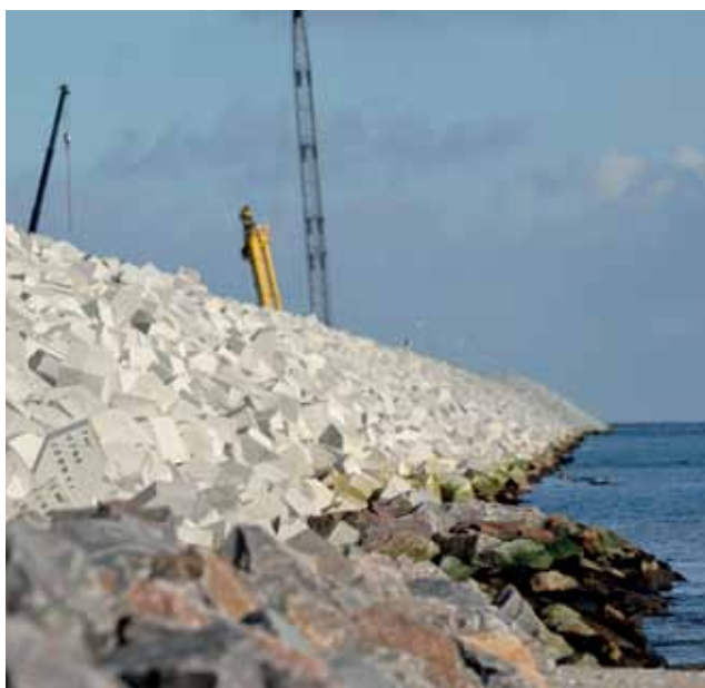
Falochron w Świnoujściu
