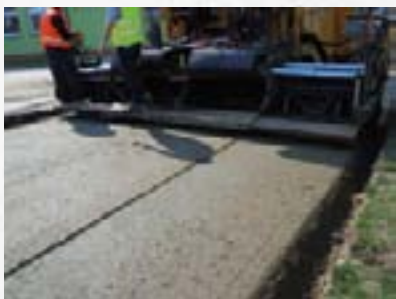
Na zdjęciach: Budowa pilotażowego odcinka drogi w technologii betonu wałowanego (RCC) w Zaklikowie.
