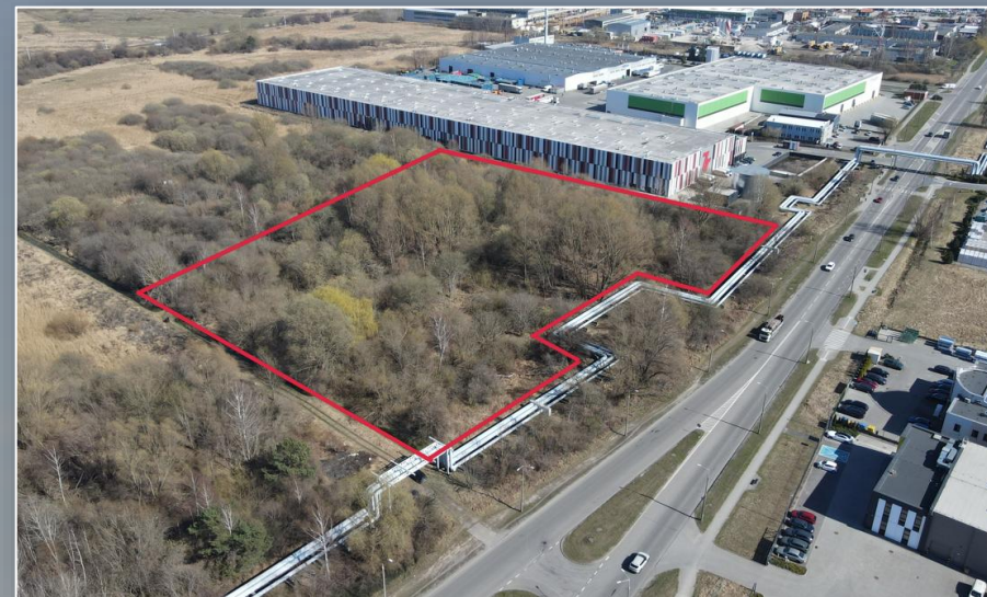
Zdj. 1 Widok na nieruchomość (stan na kwiecień 2026)
